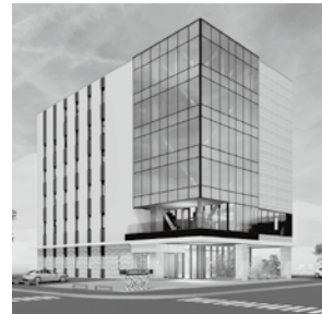
現在新社屋建設中 2026年4月完成予定
